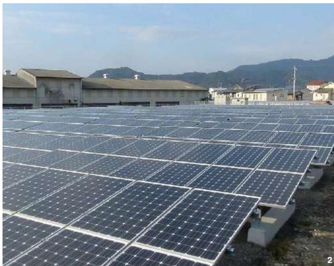
1. 木材や塗装の乾燥に必要な熱を生み出すボイラーシステム。生産過程で出る端材は無駄にせず、工場内で熱に変えてエネルギーを有効活用します。2. 新たに設置した太陽光発電パネル。発電量はおよそ120世帯分の年間使用量に相当(1世帯3,650kWh/年で計算)。売電された電気は周辺地域の電力として利用されています。
